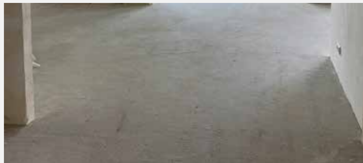
Afwerkloer van anhydriet.
