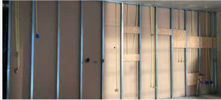
Metal-stud wanden met elektra en achterhout. Hierna wordt de wand afgewerkt met gipsplaten.
