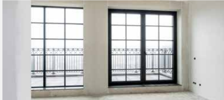
Houtskeletbouw (HSB) gevelelementen met een phermacel afwerking.
